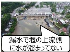
頭首工の漏水事故 (上流側より俯瞰)
